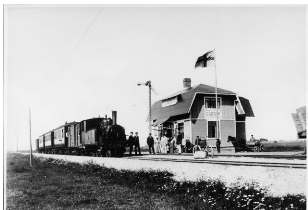
Gårdby, en typisk station på södra Öland
